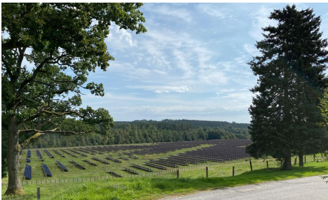
FIGUR 14. FOTOMONTAGE ÖVER DEN NORRA PARKDELEN MED UTGÅNGSPUNKT FRÅN EKERO ÄLDREBOENDE SCHEMATISKT BILD AV HUR PLACERINGEN AV SOLCELLER KAN KOMMA ATT SE UT SAMT VAR STAKETET SKALL GÅ. STAKETET KOMMER BLI MODELL VILTSTÄNGSEL.
