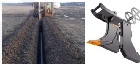
FIGUR 6 BILD PÅ KABELPLOG SOM ANVÄNDS FÖR ATT FÖRA NER KABLARNA I JORDEN
